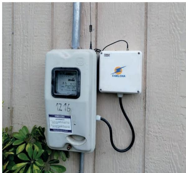
**UDAT UNIDAD DETECTORA DE AUSENCIA DE TENSION PARA USUARIOS ELECTRODEPENDIENTES.**
